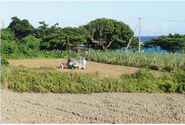
写真-4 友利元島におけるボーリングの様子 (ボーリング地点3)
